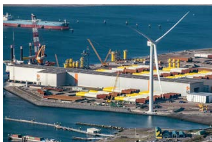
Prototyp der GE Haliade X in Rotterdam. Foto: GE Renewable Energy
