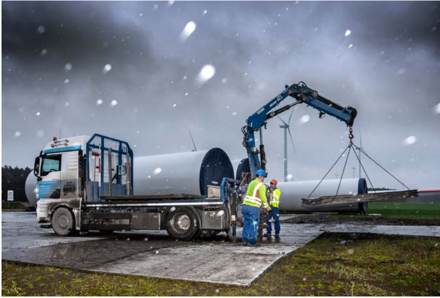
Windpark Tempelfelde Willmersdorf: Bei Schneefall präparieren Monteure den Untergrund für einen Schwerlastkran zum Aufbau einer Windenergieanlage. Foto: Paul-Langrock.de
