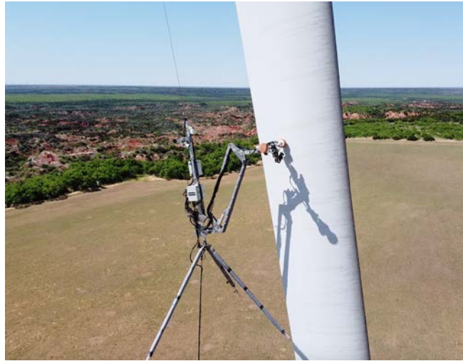
Der Leitfähigkeitstest ist wichtig, um die Kontinuität des Blitzschutzsystems im Falle eines Blitzeinschlags sicherzustellen. Foto: Aerones
