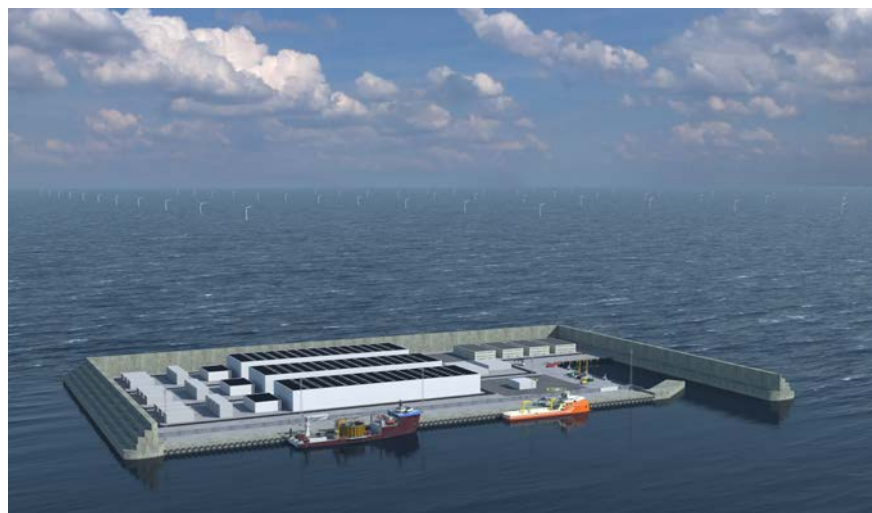
Auf einer künstlichen Insel in der Nordsee will Dänemark Strom aus Offshore-Windkraftanlagen bündeln. Auch ein Kraftwerk zur Umwandlung und Speicherung in Wasserstoff ist dort geplant. Foto (Illustration): Energistyrelsen el. Danish Energy Agency
