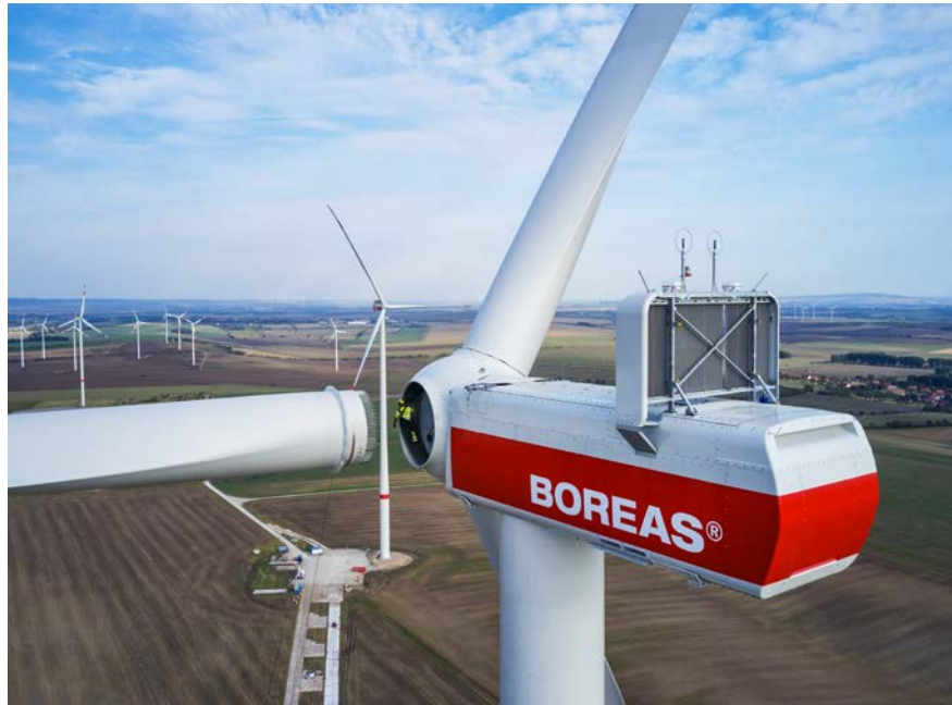
Aufbau Vestas V150-4.2 MW im Windpark Gangloffsömmern in Thüringen. Foto: Jan Oelker
